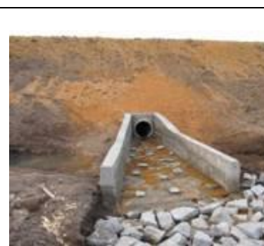
Figura 60 – Lançamento na Rede de Macro drenagem
