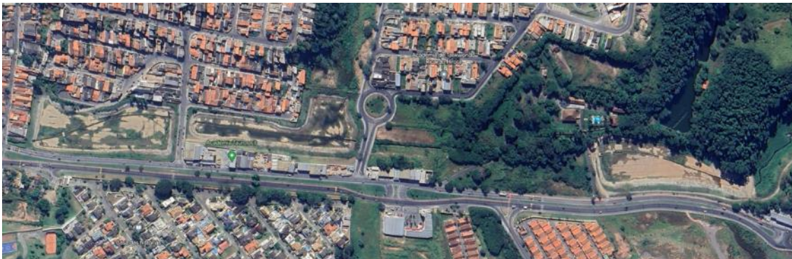
Figura 55 – Bacia de Detenção em Jacareí, SP
