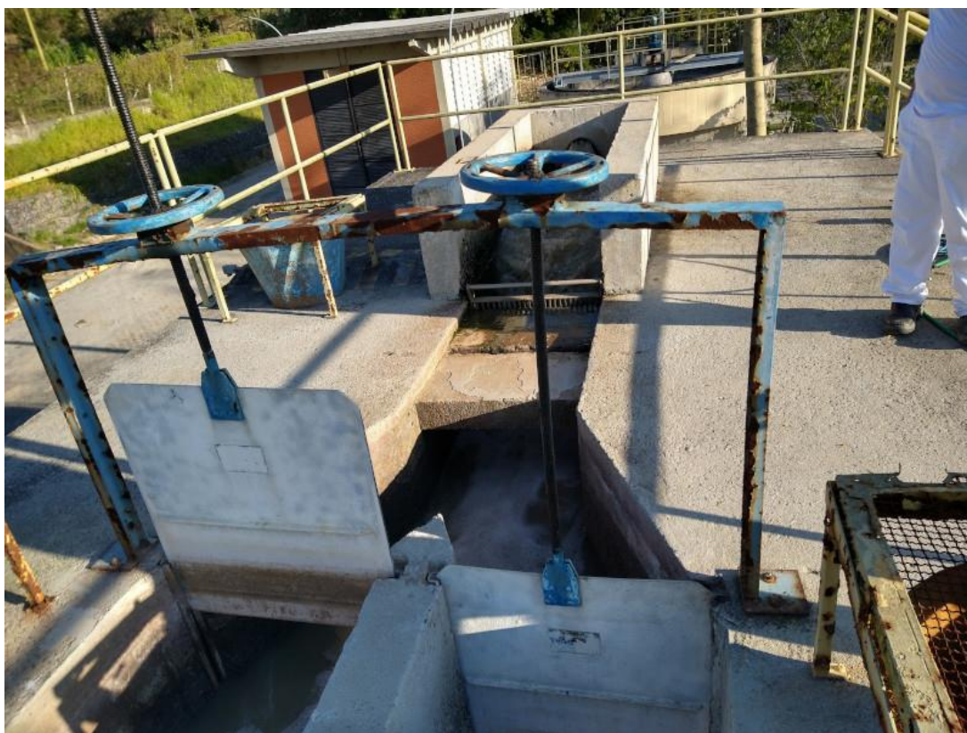
Figura 31 - Vista parcial do tratamento preliminar. Em primeiro plano comportas de entrada nas caixas de areia e ao fundo canal de chegada do esgoto bruto e gradeamento
