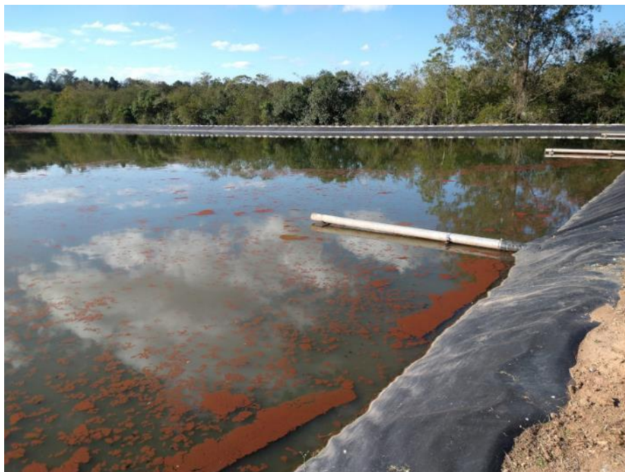
Figura 28 – Vista da região de entrada de uma das lagoas facultativas
