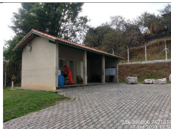
Figura 40 - Local de armazenamento de pilhas e baterias no LEV – Jardim Imperial.
