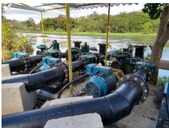
Figura 3 - Vista da captação auxiliar mais nova, fixa na margem
